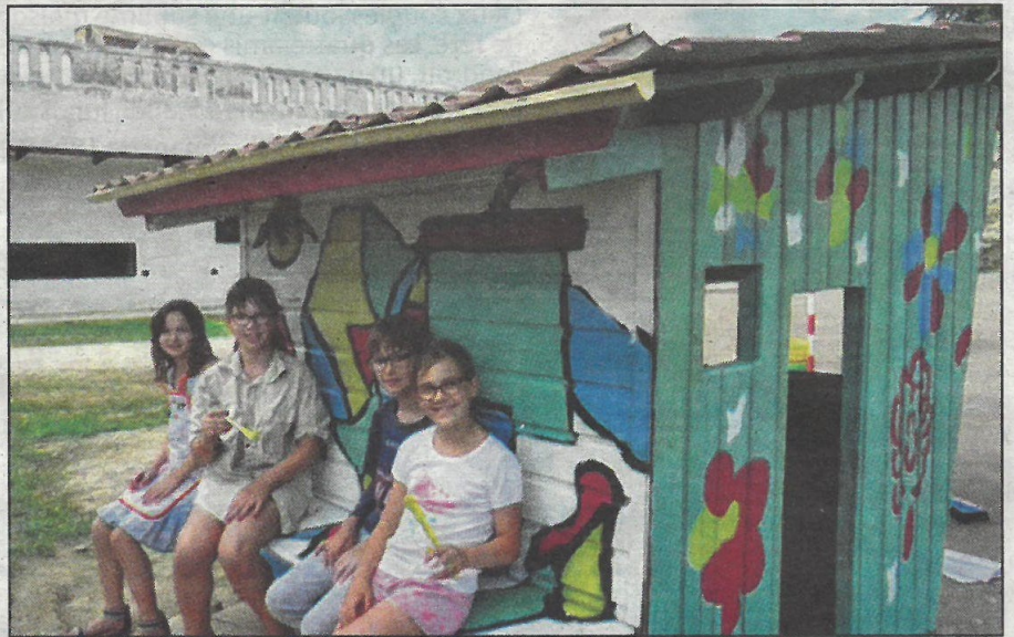
La dernière semaine d'août, les jeunes ont rénové une vieille cabane et lui ont redonné vie. PHOTO PAUL PLAZA
