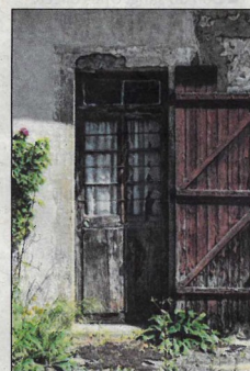
Derrière cette porte, un petit pub à l'esprit anglais sera installé.
