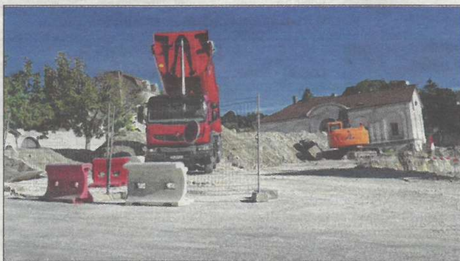
Le chantier devrait durer jusqu'en 2019. PHOTO P. P.
